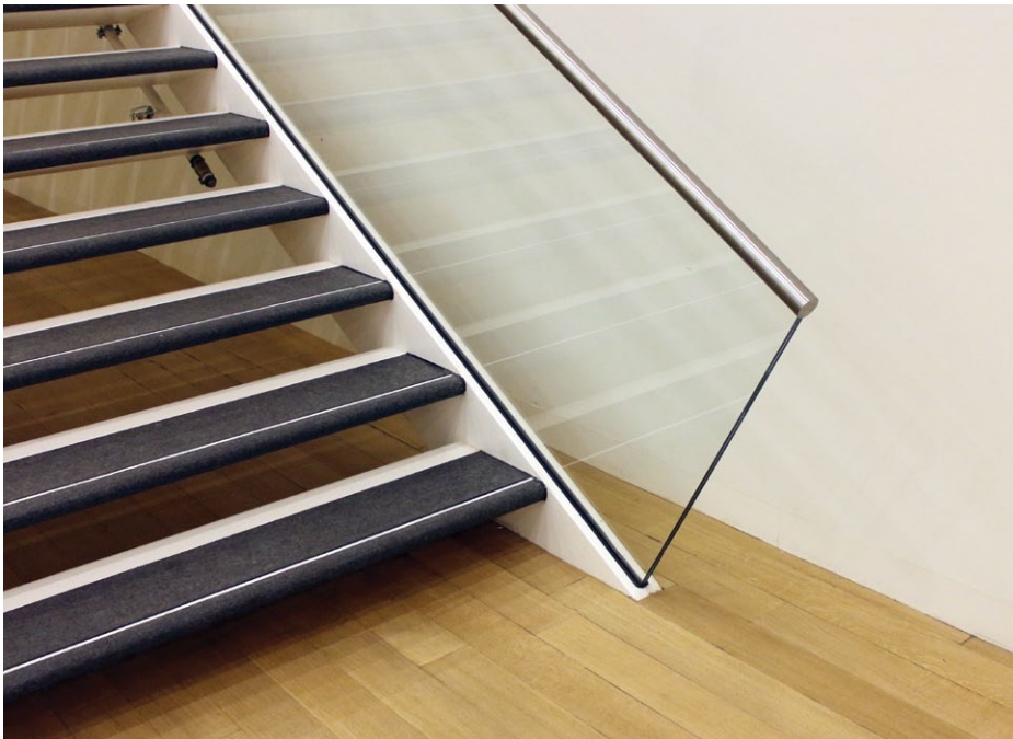
Figuur 6 a en b—Verwarrende visuele en tactiele informatie: de trederandmarkering, bedoeld voor nauwkeurige voetplaatsing op trederanden, is ook aangebracht op de bordessen. De lijnen op de trederanden zijn verzonken en daardoor niet voelbaar, op de bordessen juist wel. De knik in de leuning die het begin van de trap markeert, is bovenaan niet goed te voelen en ontbreekt aan de onderkant. Stedelijk Museum Amsterdam. (Ontwerp: Bentheim Crouwel)
