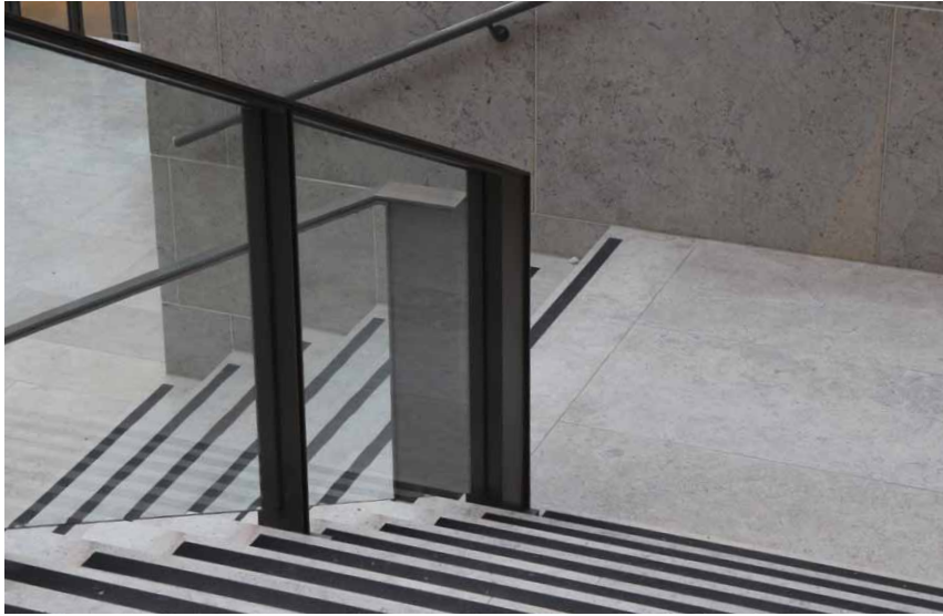
Figuur 1 — De ad hoc aangebrachte trederandmarkering blijkt een goede oplossing om het valrisico bij de entree van het Rijksmuseum permanent te verkleinen.
